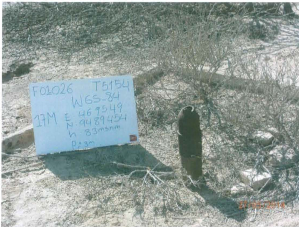
Fotografía N° 1. Pozo inactivo sin cabezal ni válvula que asegure su hermetismo se encuentra expuesto al ambiente.
