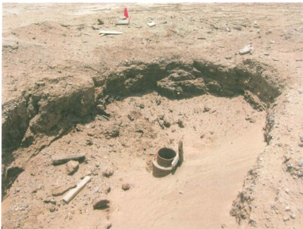
Fotografía N° 1. El Pozo T1705 se encuentra en un hoyo, donde se observa el casing abierto y expuesto al ambiente.
