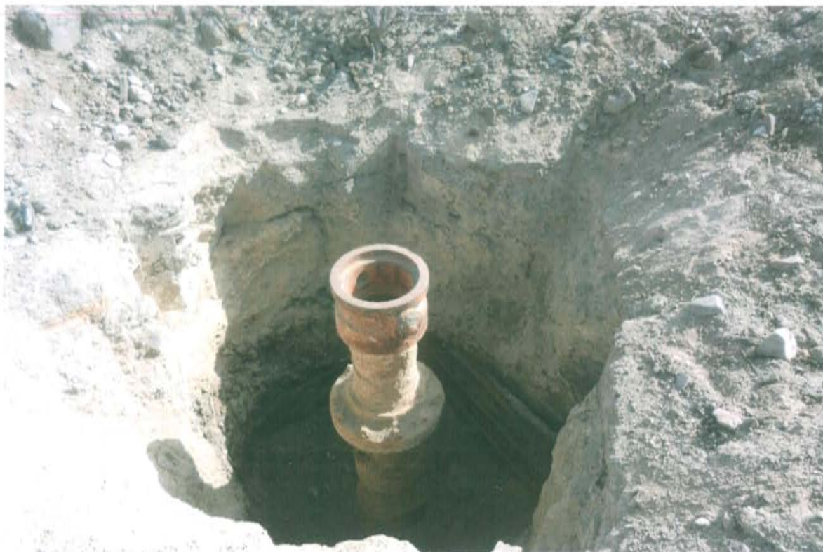
Fotografía N° 1. Pozo con código PERUPETRO T2427 y código Ficha OEFA F01234, se observa el casing corroído que presenta cabezal compuesto por unas bridas y tuberías de reducción, sin ningún accesorio de cierre por lo que se encuentra abierto al ambiente.
