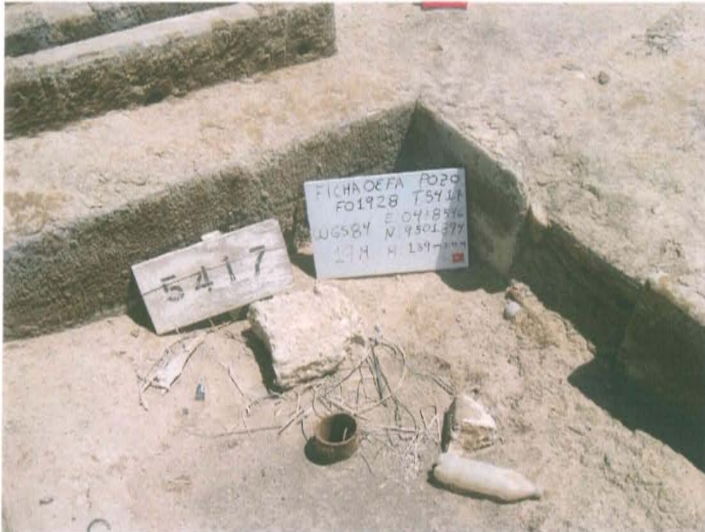
Fotografía N° 1. Identificación del pozo inactivo con código PERUPETRO T5417. Presenta casing abierto al medio ambiente.
