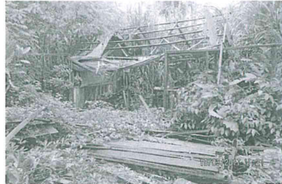
Fotografía N° 6. Estructura de madera utilizada como oficina por el campamento anteriormente instalado, ubicada al lado izquierdo del canal de flotación.
