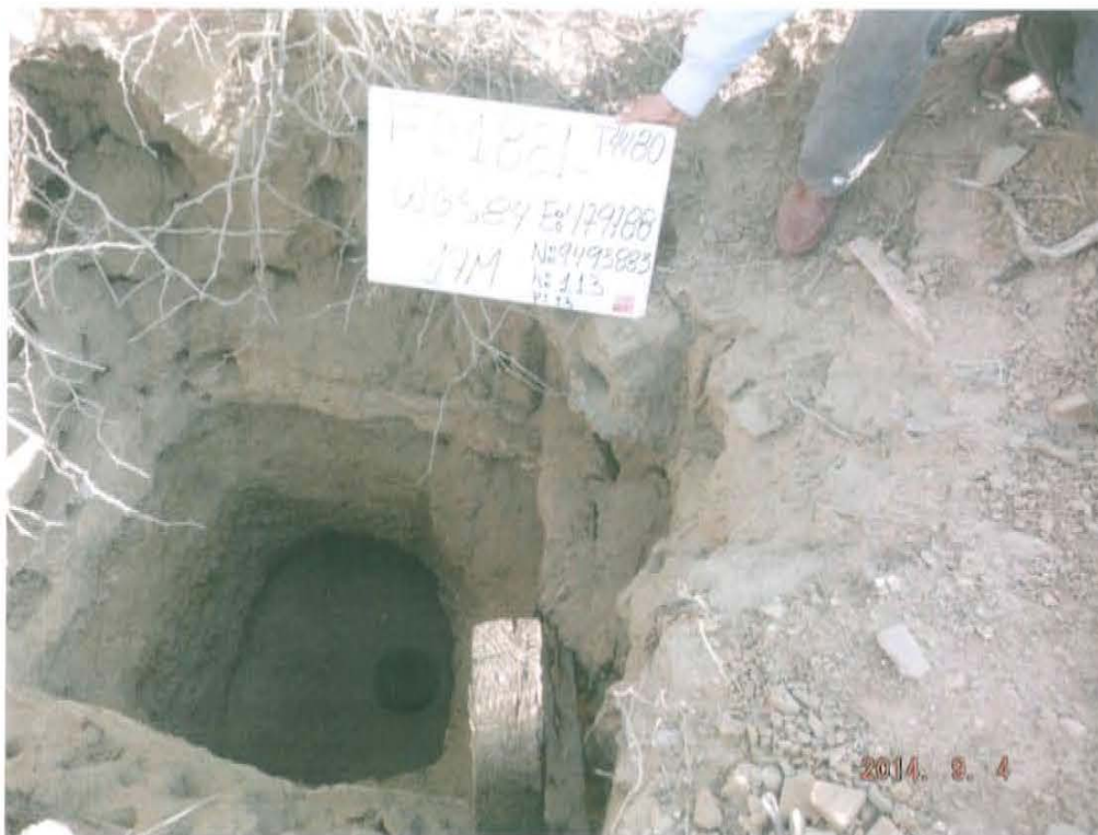
Fotografía N° 1. Pozo inactivo con código PERUPETRO T4480, no posee cabezal y se encuentra dentro de hoyo de aproximadamente 3 m de profundidad.
