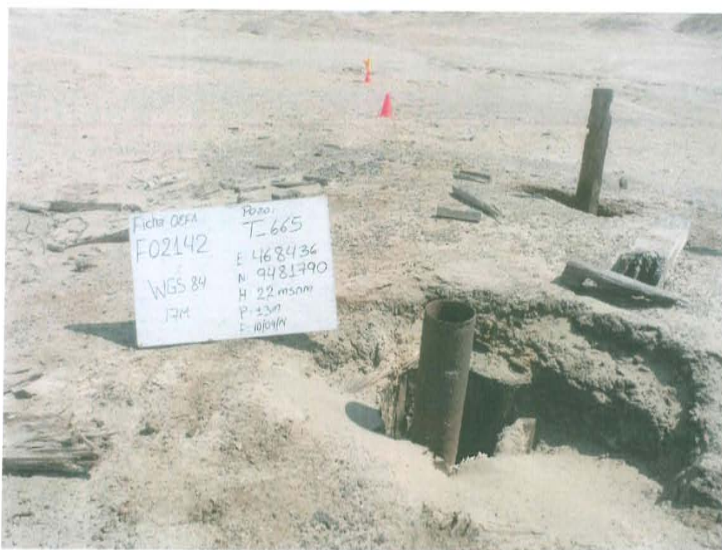
Fotografía N° 1. Se observa casing corroído que sobresale del interior de un hoyo y se encuentra abierto al ambiente.
