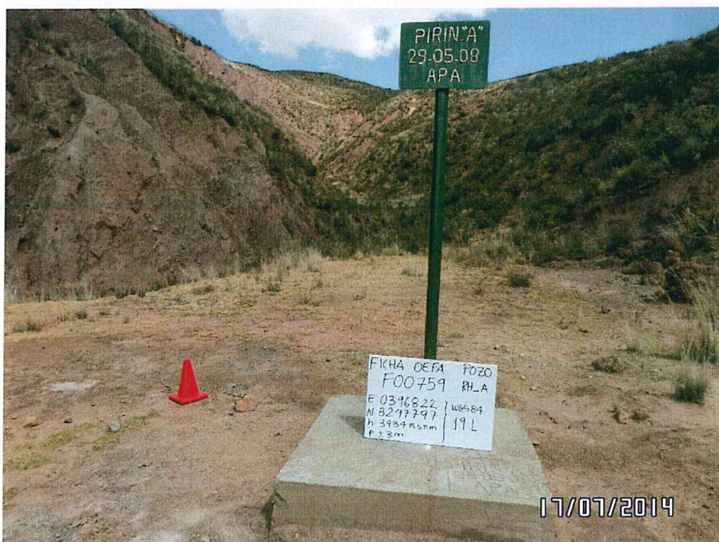
Fotografía N° 2. Vista de Pozo RH__A. La altura de la varilla de acero es de 2 m en relación, a una losa de concreto 2m X 3m.
