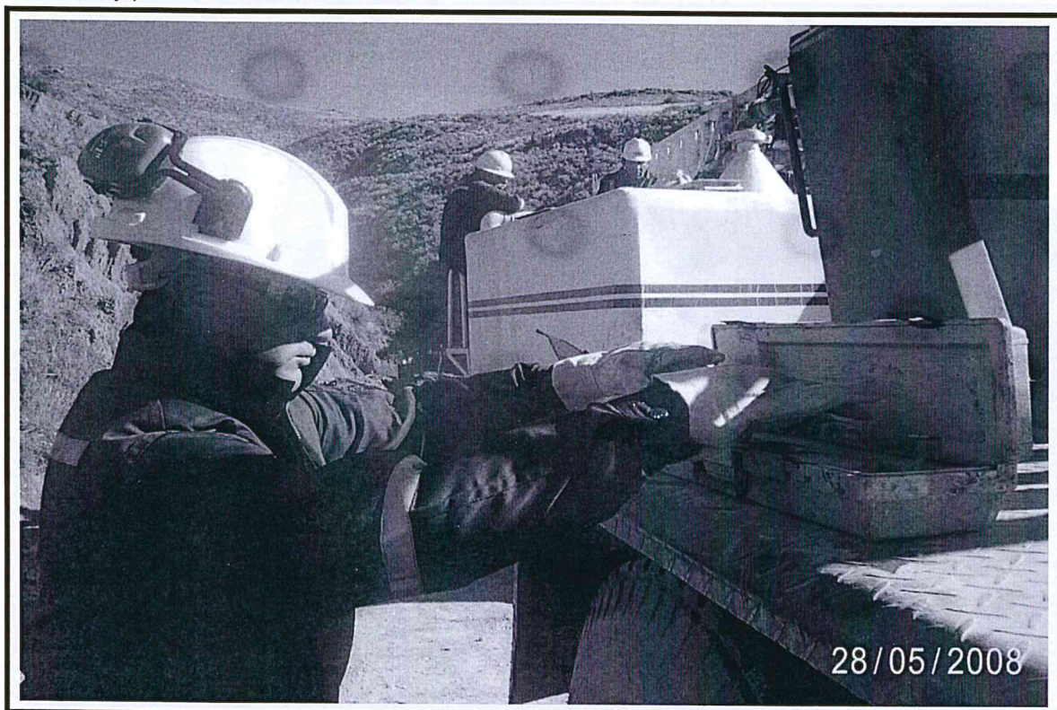
Foto 14. Ing. Lucas Arista, efectuando la medición de densidad de la lechada de cemento.
