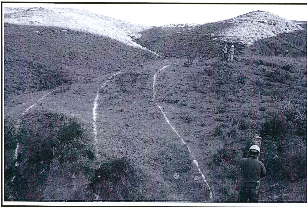
Foto 1. Efectuando trazos topográficos por donde se proyectará el camino de acceso al pozo Pirin A
