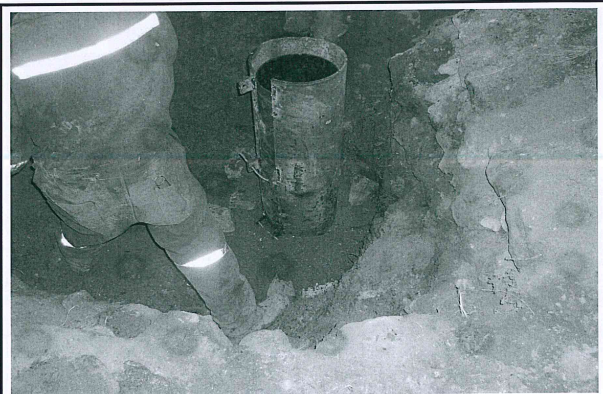
Foto 8. Colocando camisa exterior al tubo de 13 3/8" para cubrir los huecos y luego se procedió a cementar parte de la cantina para fijar camisa y evitar futuras fugas.
