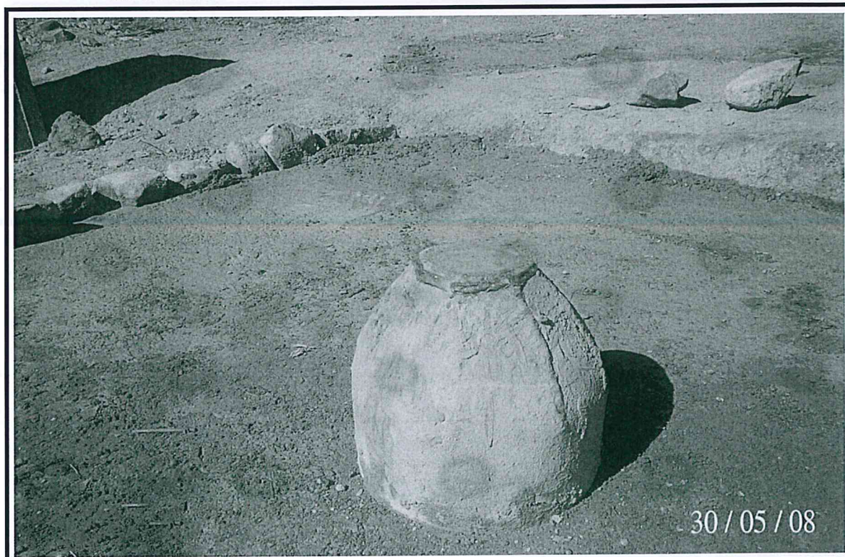
Foto 16. Se visualiza el cabezo del pozo con su tapa soldada y posteriormente se procederá al encofrado y posterior losa de cemento.
