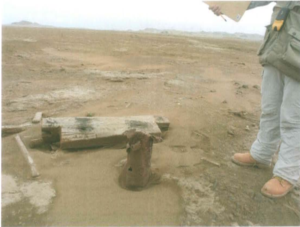
Fotografía N° 1. Pozo inactivo con código PERUPETRO T_586. Se observa conductora sobresaliendo una altura de 0,3, m sobre la superficie.
