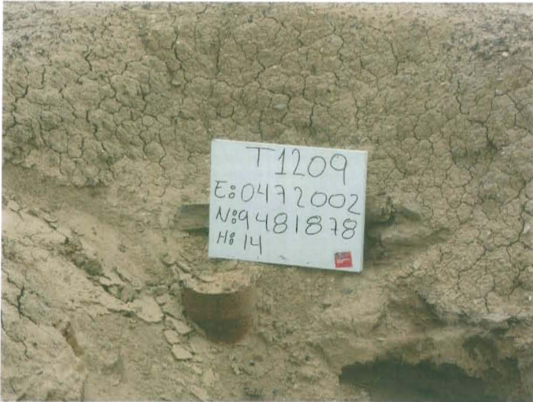
Fotografía N° 1. Pozo inactivo mal abandonado de la Ficha OEFA F00413, presenta casing en el interior de un hoyo con acumulación de arena en el interior del casing.
