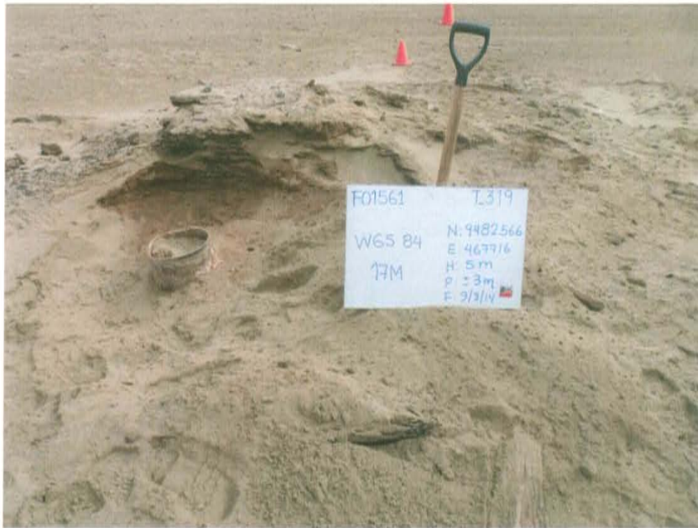
Fotografía N° 1. Se observa el casing a una altura de 0,2 m sobre el nivel de la superficie correspondiente al pozo inactivo con código PERUPETRO T_319.
