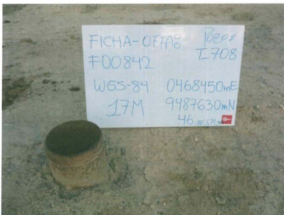
Fotografía N° 2. Se observa pozo inactivo que presenta una casing que se encuentra abierto, sin elemento de cierre en superficie tales como válvulas, llaves entre otros que garanticen un cierre hermético del pozo.
