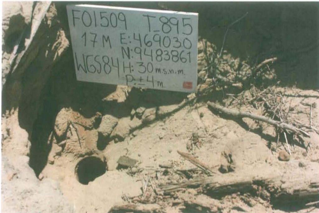
Fotografía N° 1. Pozo T_895, presenta casing de aproximadamente 7 pulgadas de diámetro cortado y corroído.
