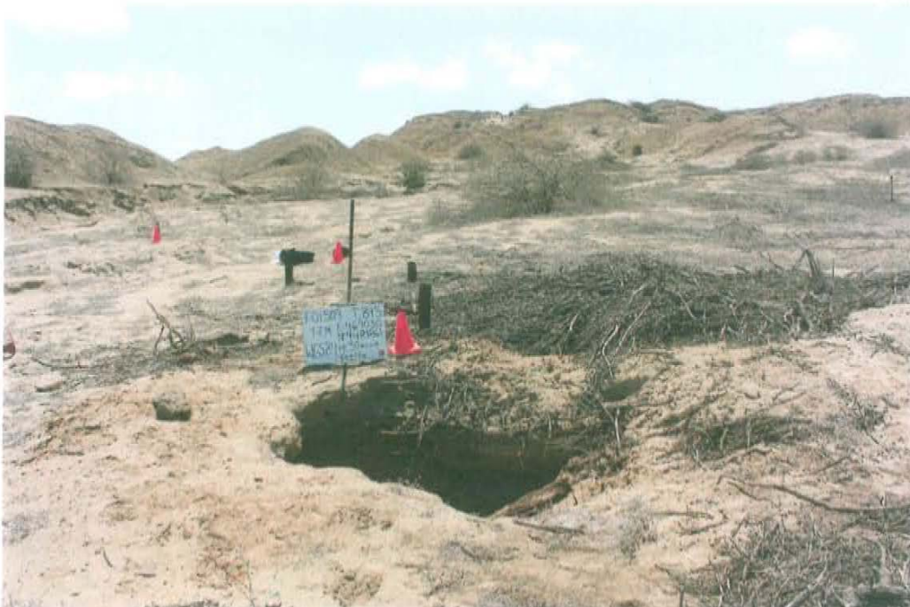
Fotografía N° 2. El pozo se encuentra dentro de un hoyo de aproximadamente 1,4 m de profundidad.
