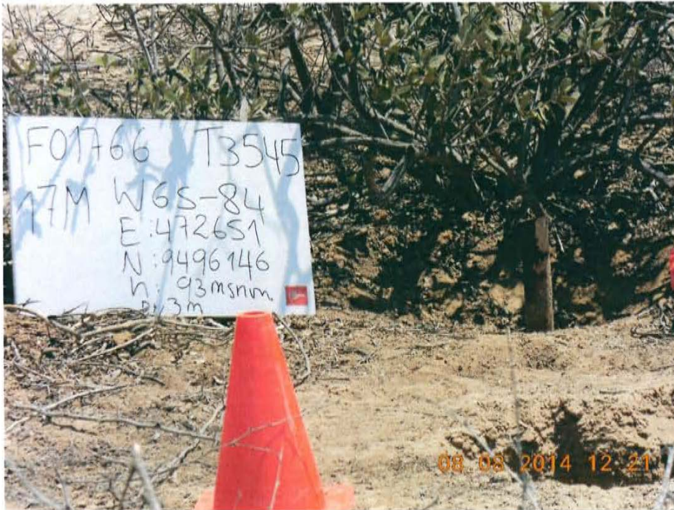
Fotografía N° 3. Se visualiza una tubería de 2 1/2 pulg de diámetro abierta al ambiente que sobresale 0,23 m debajo de un arbusto de Vichayo.
