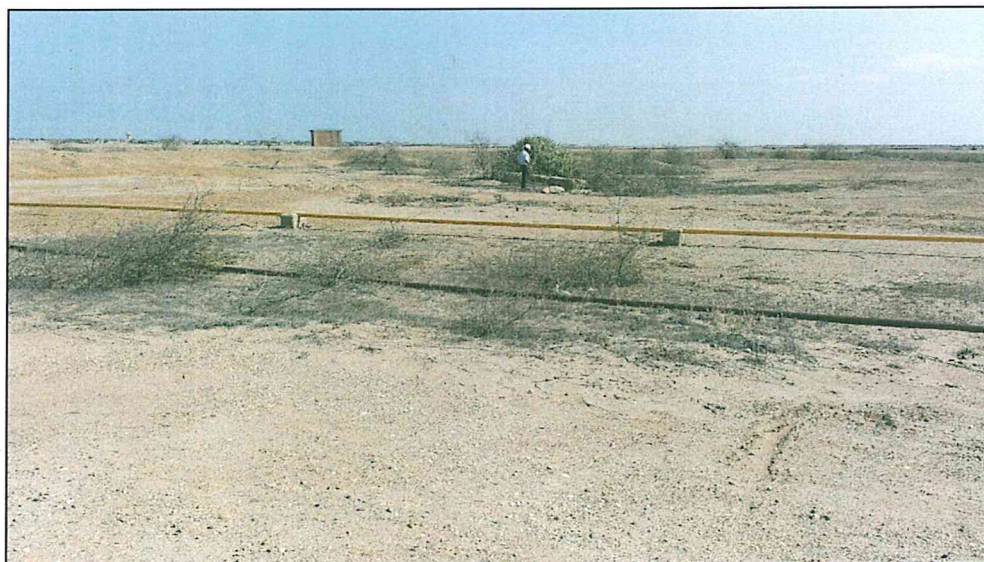
Fotografía N° 3. Vista de la línea de conducción de hidrocarburos existente al lado sur del Pozo T2425.
