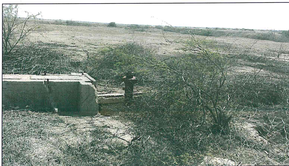
Fotografía N° 2. Ubicación del casing invadido por la vegetación de la zona, asimismo hay una estructura de cemento que ha sido base de la unidad de bombeo mecánico
