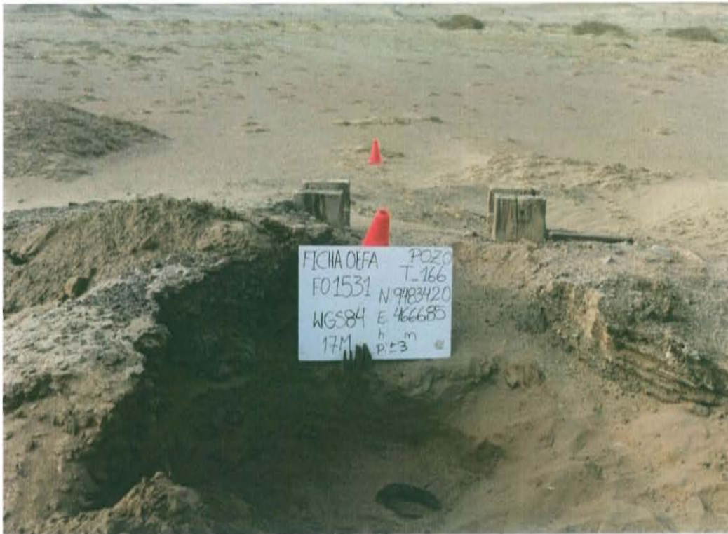
Fotografía N° 1. Identificación del pozo inactivo con código PERUPETRO T_166. Presenta casing apenas visible debido a la acumulación del material eólico en el fondo de una excavación.
