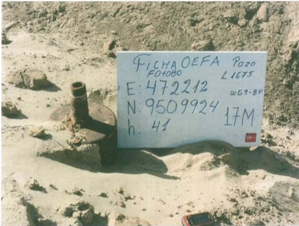
Fotografía N° 1. Identificación del pozo inactivo con código PERUPETRO L1675. Presenta casing corroído con tubería de reducción expuesta a la intemperie.
