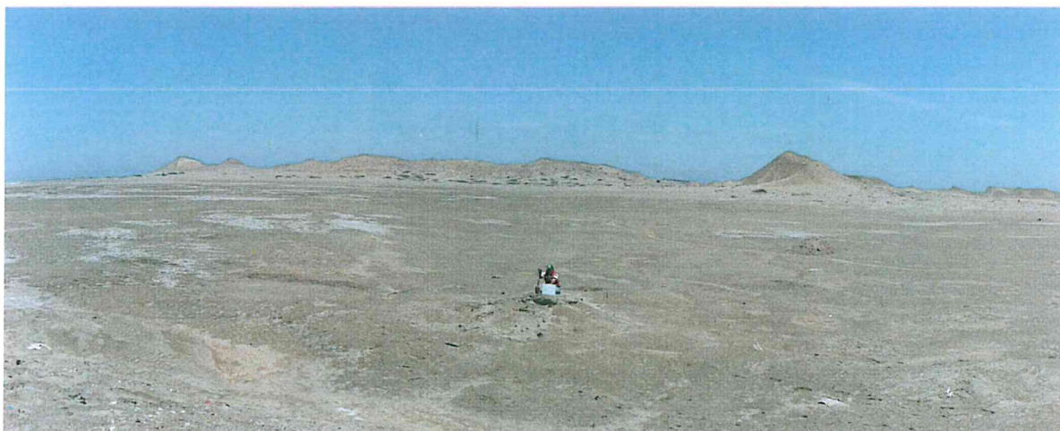
Fotografía N° 2. Vista panorámica del Pozo T_839 mal abandonado, se observa que no tiene terraplén ni acceso.
