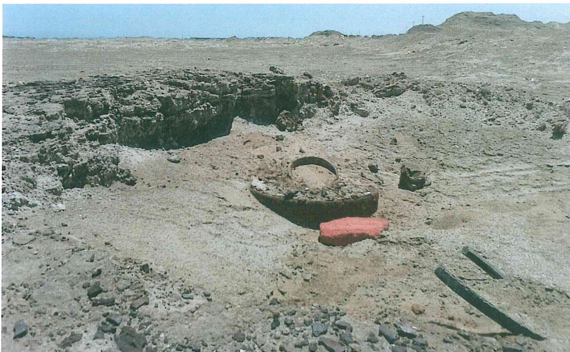
Fotografía N° 1. Vista del pozo inactivo con código PERUPETRO T_839, se observa el casing de superficie descubierto y en el interior del casing de superficie sobresale 0,1 m el casing de producción, ambos colmados de arena en su interior.
