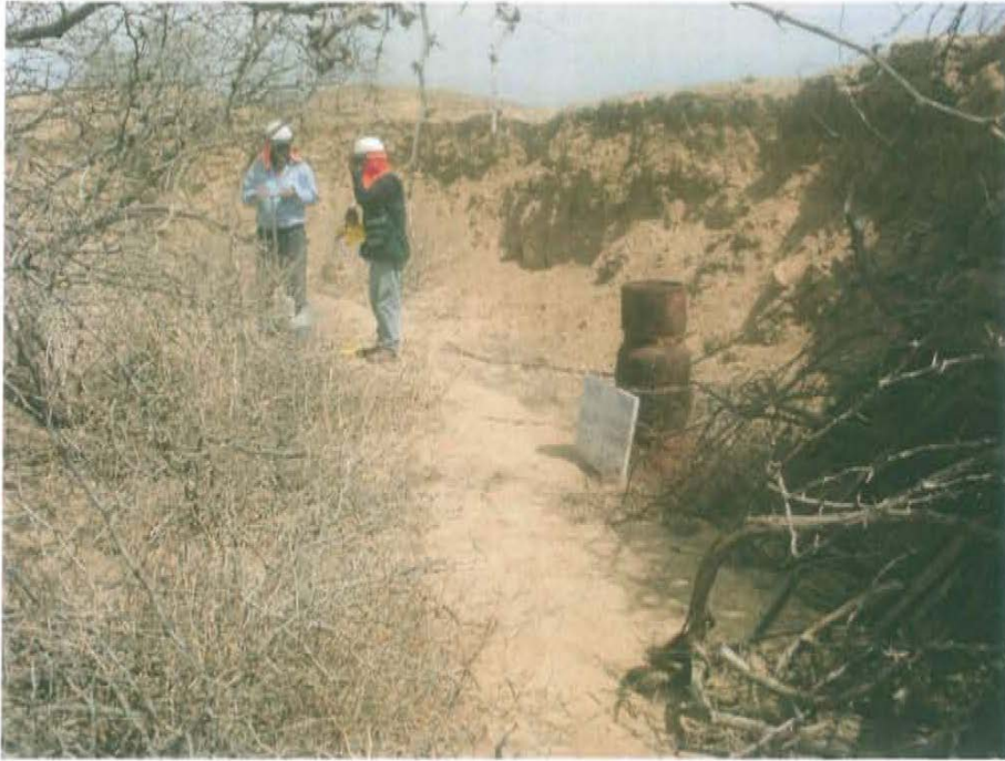
Fotografía N° 3. Del interior de pozo se perciben emisiones gaseosas y se observa fluido interno
