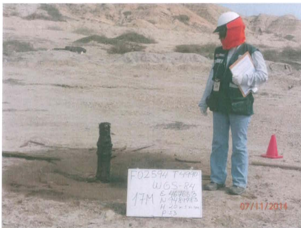
Fotografía N° 1. Ubicación del pozo inactivo con el casing abierto y expuesto al ambiente.
