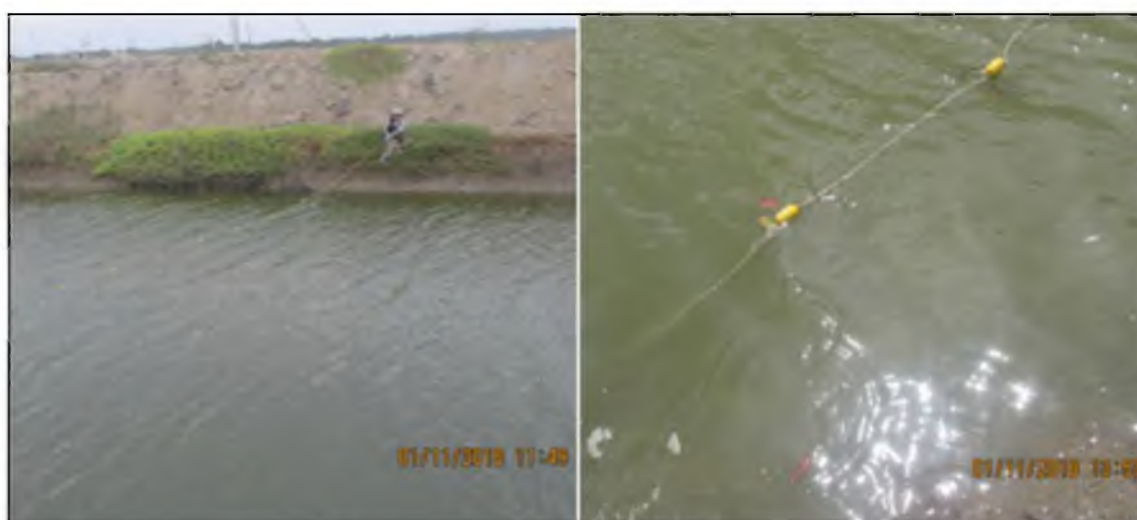
Figura 7.1. Canal artificial Hualtaco, EB Hualtaco, Centro de producción acuícola Marinazul
