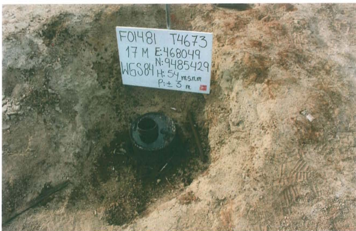
Fotografía N° 01.- Pozo con código PERUPETRO T4673 con Ficha OEFA F01481, se observa el casing con fluido en su interior y una tubería, ambas abiertas al ambiente.
