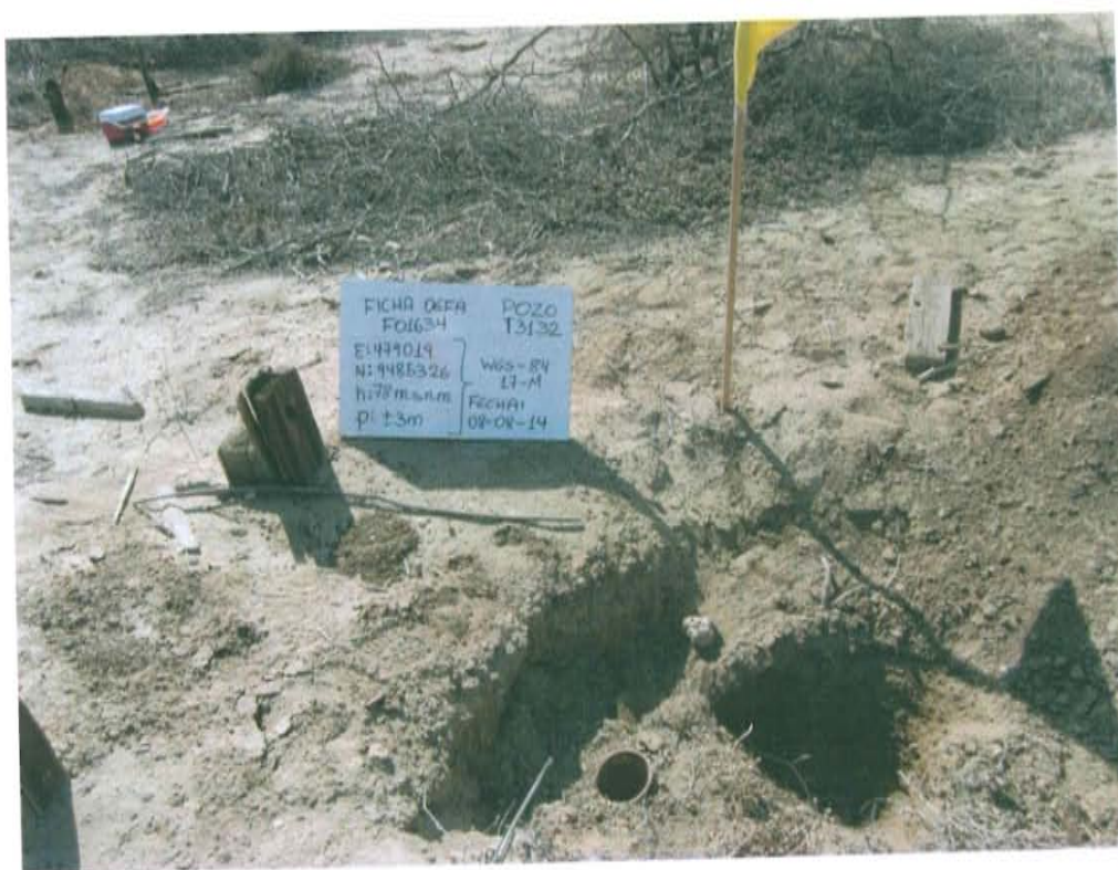
Fotografía N° 1. Pozo inactivo con código PERUPETRO T3132. Se observa casing a nivel de superficie de suelo.
