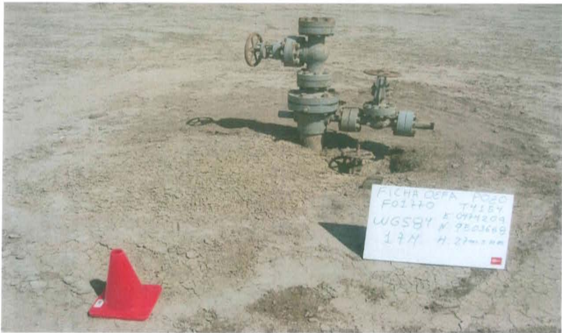
Fotografía N° 1. Pozo con código PERUPETRO T4154 y código Ficha OEFA F01770, se observa el casing corroído con cabezal compuesto de una brida reductora, dos (2) válvulas y un arreglo de tuberías que por sus condiciones se encuentran abiertas al ambiente.
