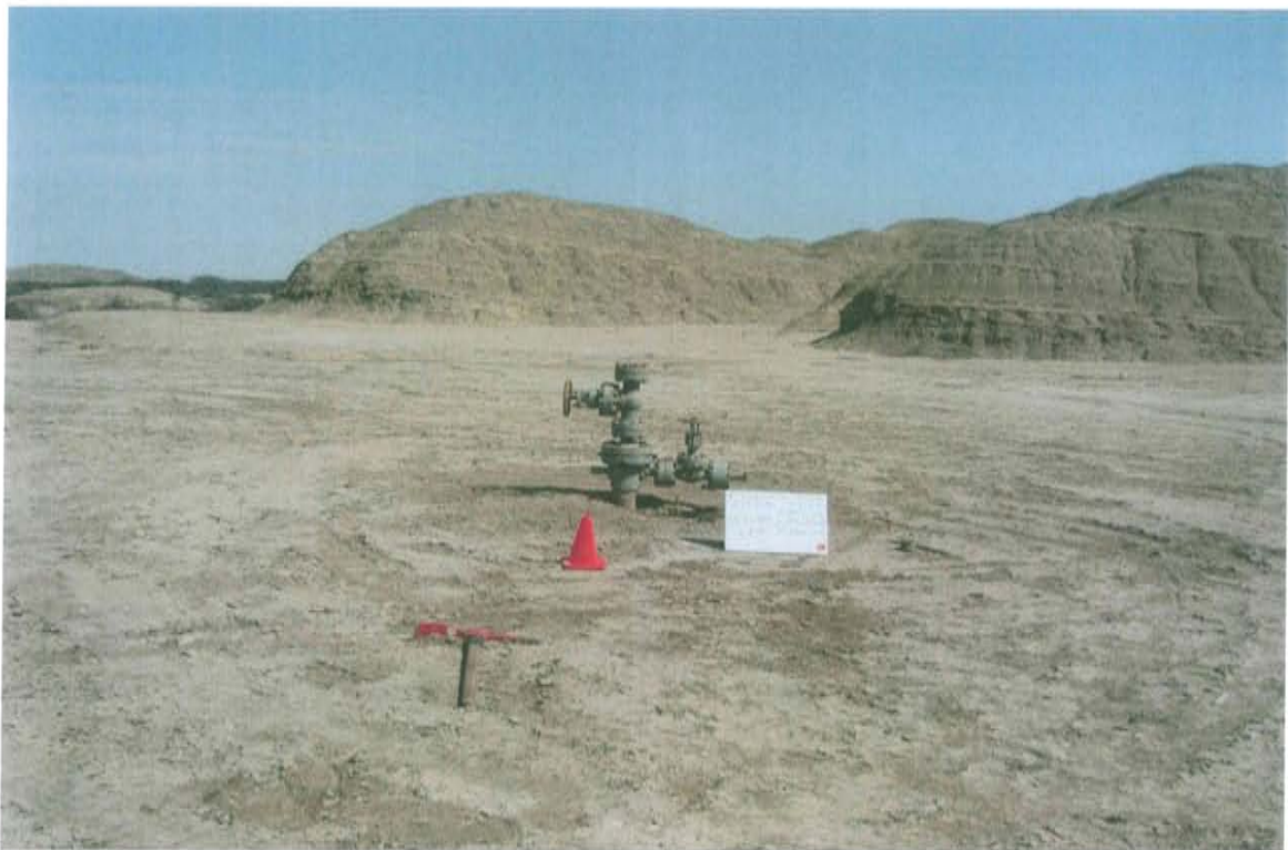
Fotografía N° 2. Vista panorámica del pozo T4154, se aprecia el terreno habilitado tipo terraplén; así como, colinas alrededor del área circundante al pozo.
