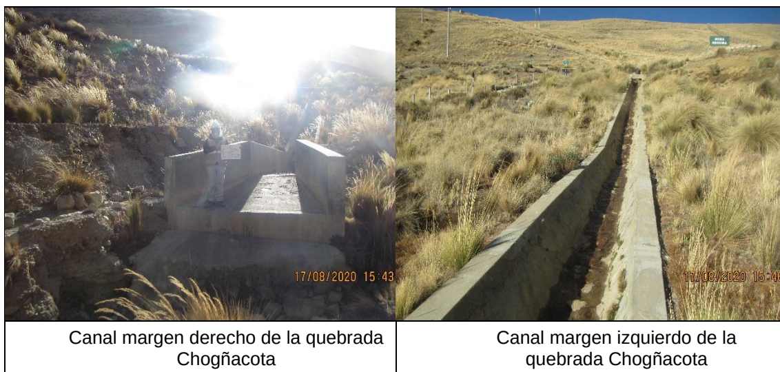
Fotografía 7.1. Canales de agua de no contacto tomadas en agosto de 2020
