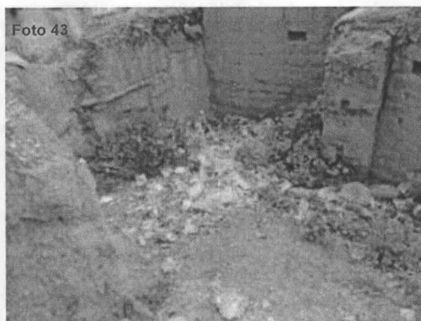
Fotografía N° 43. Evidencia de la acumulación de residuos sólidos, en el punto georeferenciado N° 2, del Cuadro N° 8. Coordenadas UTM WGS 84 (18L 291253E 8806445N)
