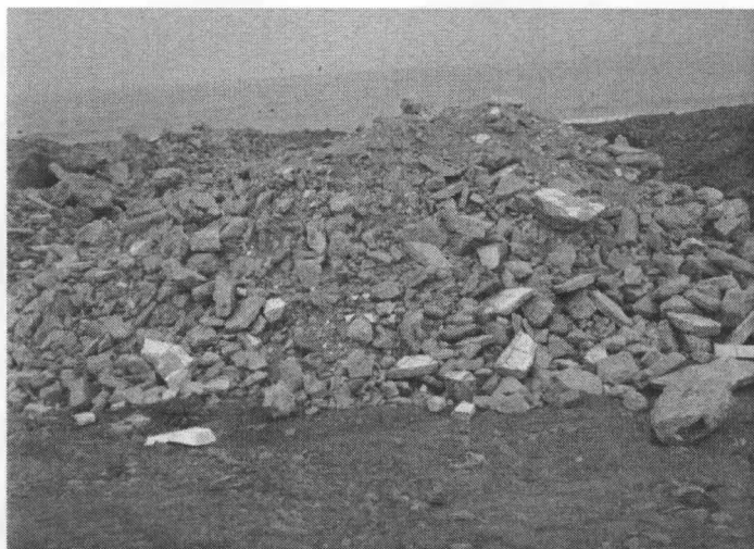
Fotografía N° 26 Evidencia de Residuos de Construcción frente al cuartel de Infantería de la Marina del Distrito de Ancón Coordenadas UTM WGS 84 (18 L 263473E 8700043N)
