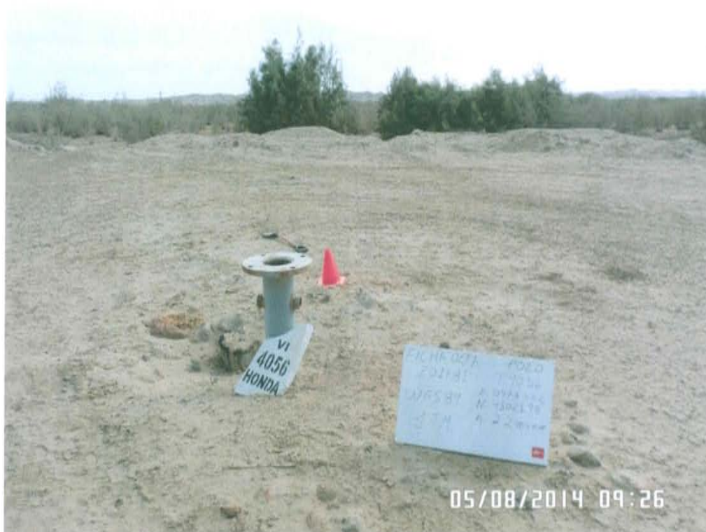
Fotografía N° 1. Vista pozo T4056 ubicado en una planicie, se observa el casing expuesto al ambiente.
