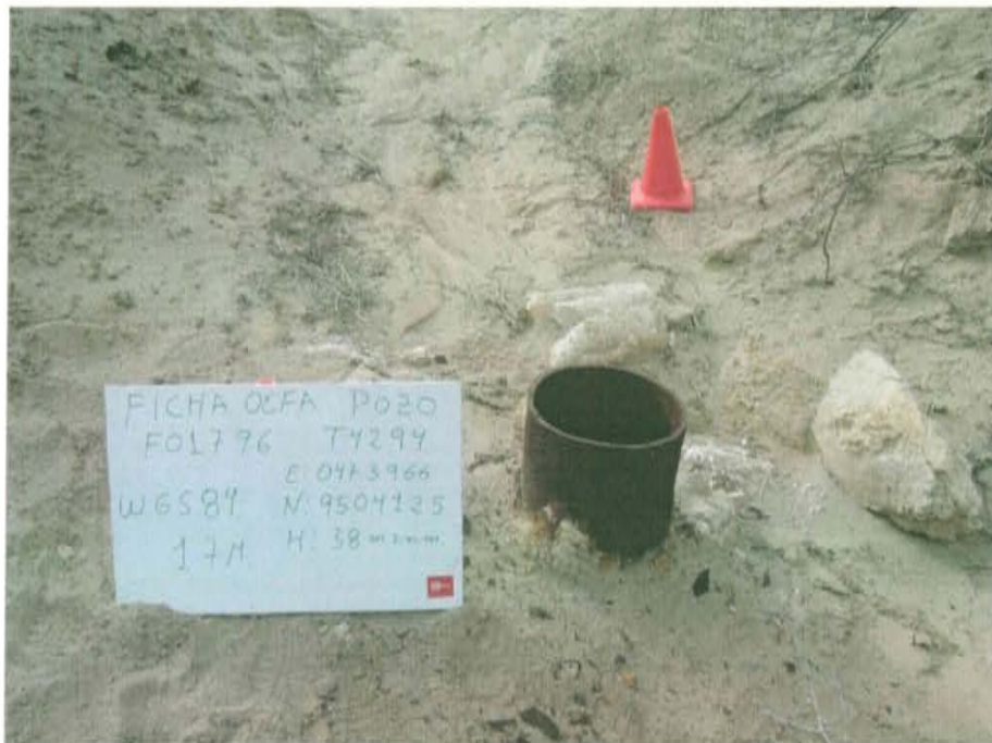
Fotografía N° 2. Se puede apreciar el casing corroído, abierto sin elementos de cierre en superficie.
