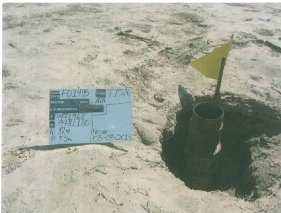
Fotografía N° 1. El Pozo T1526 presenta casing abierto sin cabezal ni válvulas que aseguren su hermetismo.
