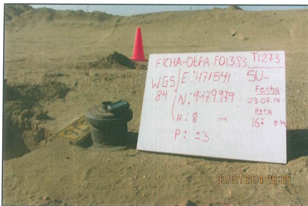
Fotografía N° 2. Pozo con código PERUPETRO T1273, con casing en estado de corrosión y sin elementos de cierre.
