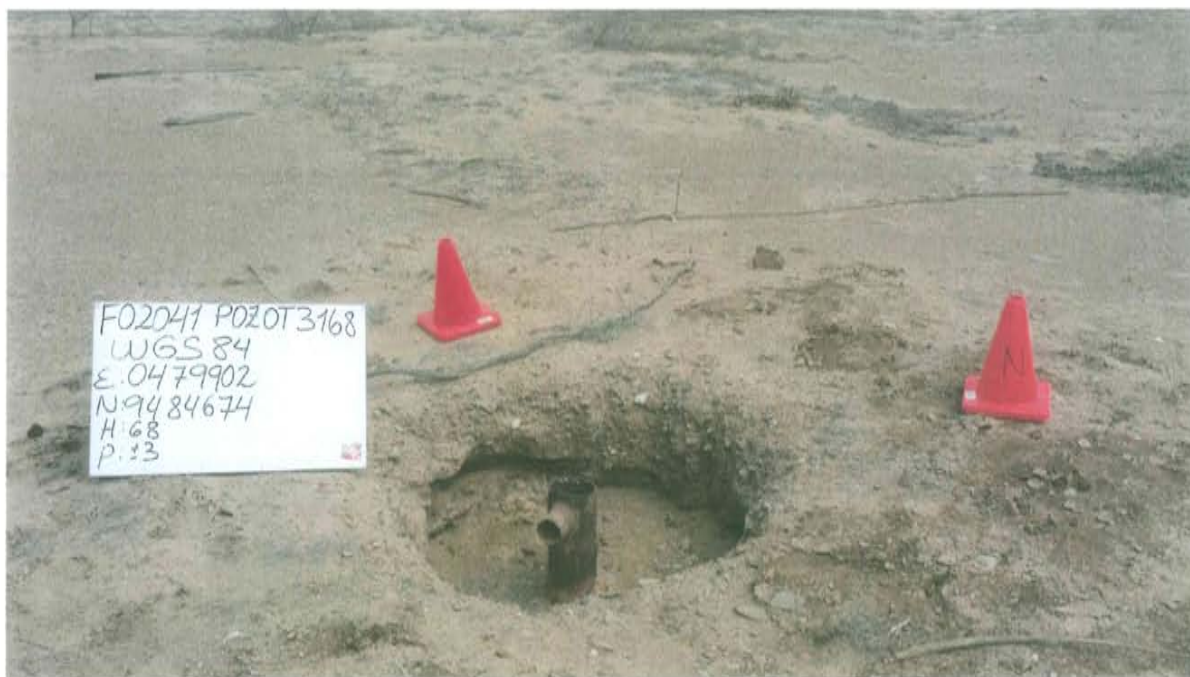
Fotografía N° 1. Pozo inactivo con código PERUPETRO T3168 donde se observa un casing cortado y corroído en el interior de un hoyo de aproximadamente 0,35 m de profundidad.
