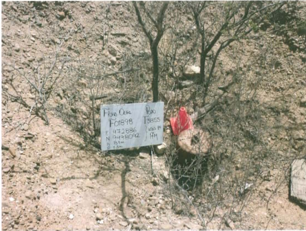
Fotografía N° 1. Identificación del pozo inactivo con código PERUPETRO T3855. Presenta casing sin válvulas que aseguren su hermetismo.
