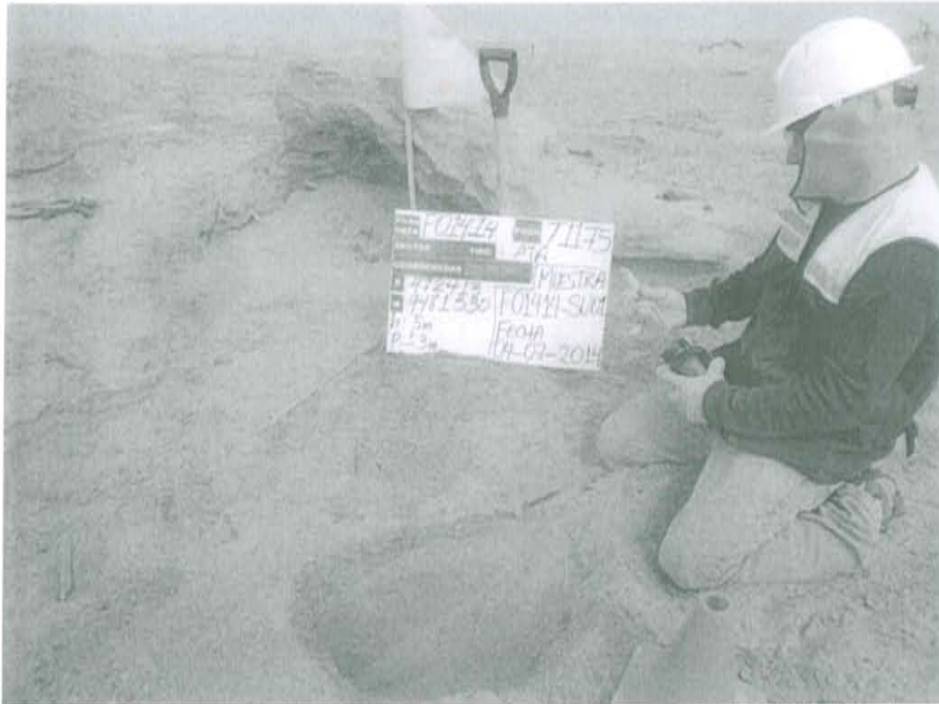
Fotografía N° 1. Toma de muestra de suelo en el punto F01414-SU01, ubicado a 2,30 m de distancia del Casing, Pozo T1175.
