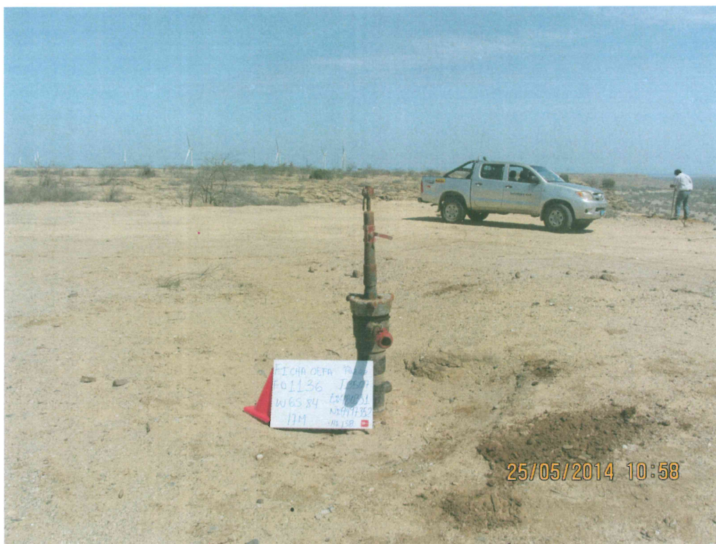
Fotografía N° 1. Se observa el cabezal del pozo compuesto por una tubería, una brida y dos (02) válvulas con signos de corrosión que posiblemente no garantiza el cierre hermético del pozo.
