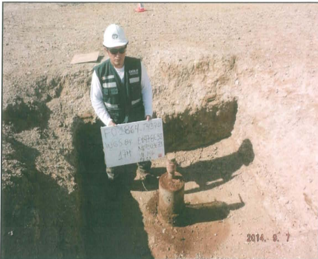
Fotografía N° 1. Pozo inactivo que se encuentra dentro de hoyo de 1,8 m x 1,8 m y 0,5 m de profundidad.
