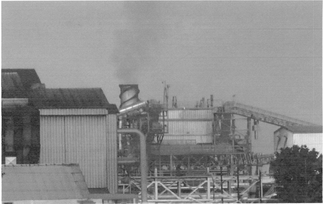
Fotografía 12. Inicio de operaciones
