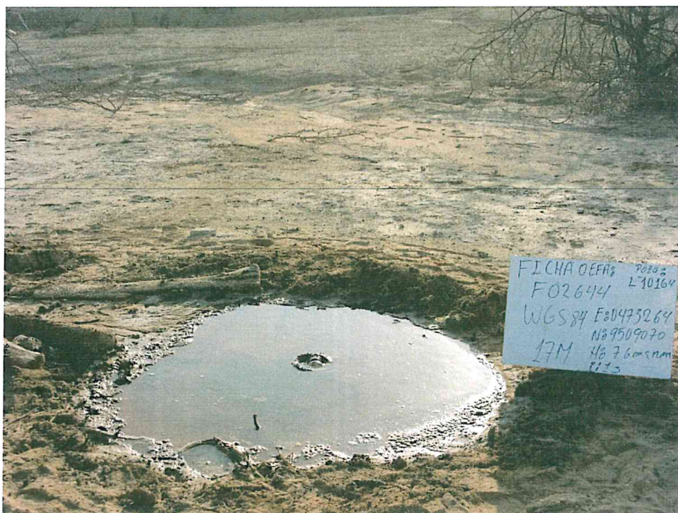
Fotografía N° 1. Pozo inactivo en terreno no habilitado sin acceso vehicular directo, se encuentra dentro de un hoyo erosionado con presencia de agua posiblemente de origen pluvial. No se observó superficialmente el cabezal del pozo, se visualizó casing de 5 pulgadas de diámetro.
