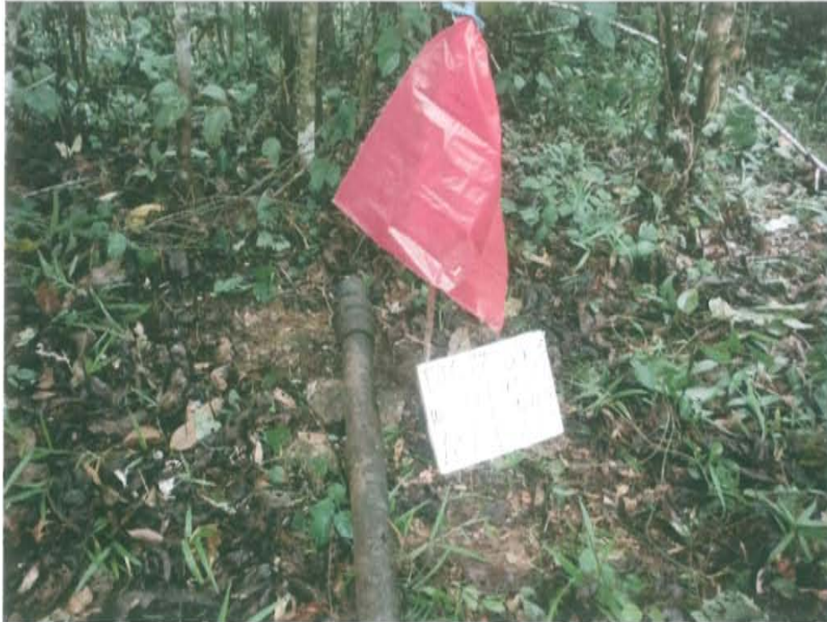
Fotografía N° 1. Vista donde se observa la tubería de revestimiento cortado desde la base y encontrado fuera de su posible ubicación.
