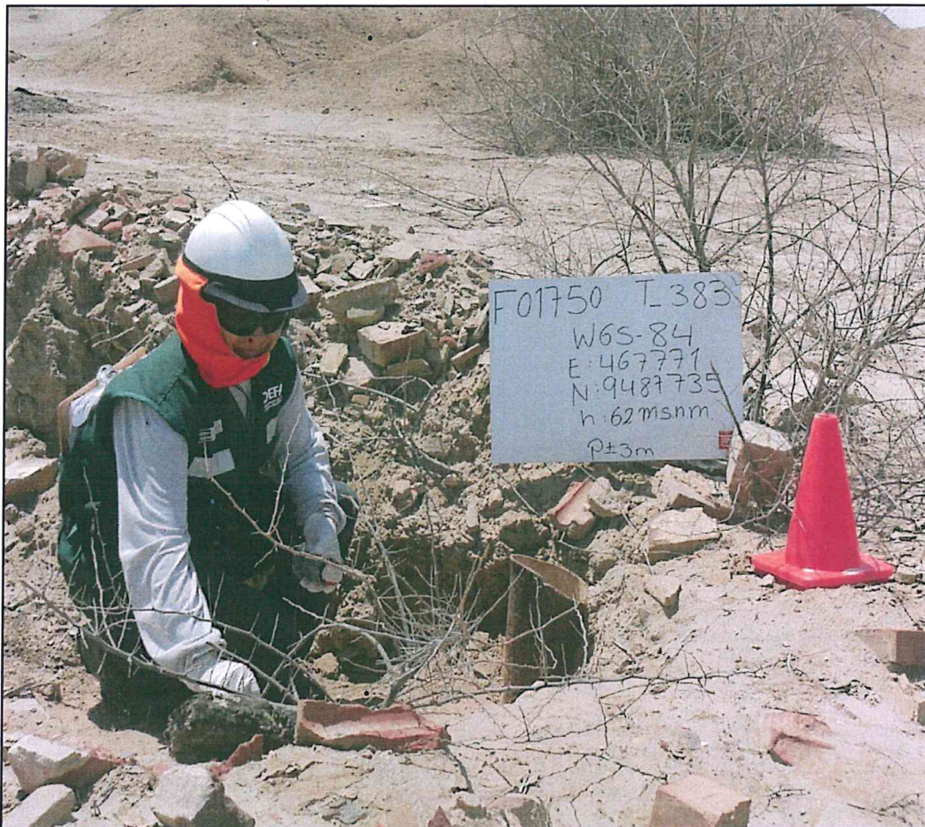
Fotografía N° 1. Pozo T_383 que presenta casing corroído de 8,5 plg que se encuentra relleno de tierra y cortado a los 0,4 m de altura dentro de un hoyo de 0,4 m de profundidad.
