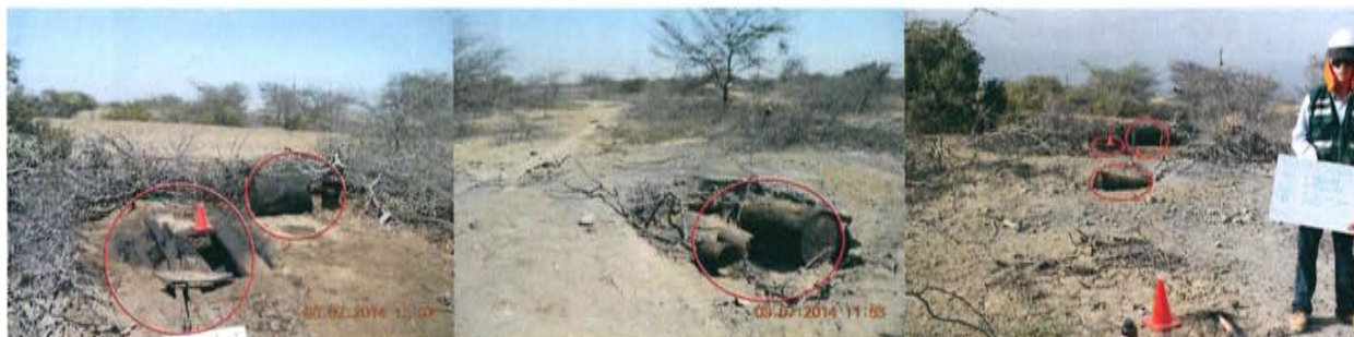
Fotografía N° 3. Vista de implementos utilizados por las personas del lugar para la extracción ilegal de hidrocarburo.
