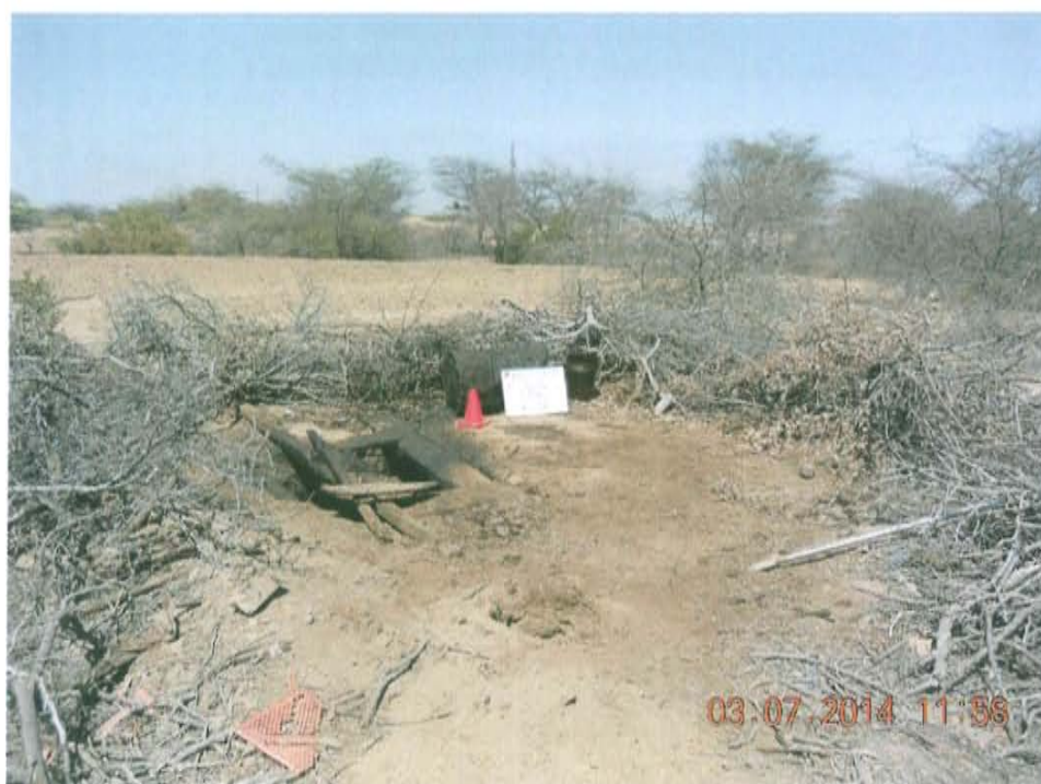
Fotografía N° 2. Pozo ubicado posiblemente en el interior de un hoyo de sección 2,72 m 2 cubierto por maderas y puntales.
