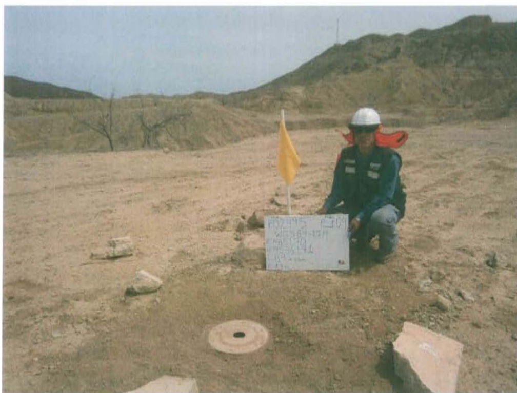
Fotografía N° 1. Identificación del pozo inactivo con código PERUPETRO P_109. Presenta casing con tapa de brida, con una ranura que expondría al pozo a la intemperie.
