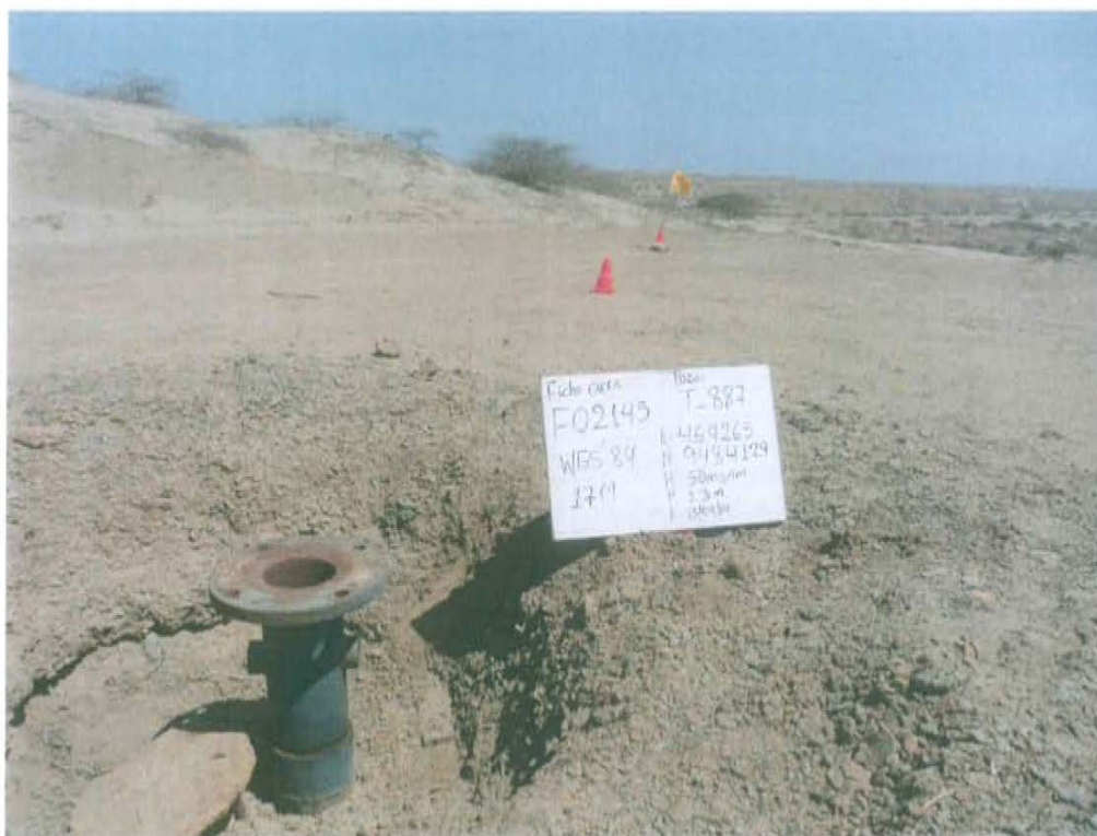
Fotografía N° 1. Identificación del pozo inactivo con código PERUPETRO T_887. Presenta casing corroído con tapa de brida adaptadora y tuberías laterales, expuestas a la intemperie.
