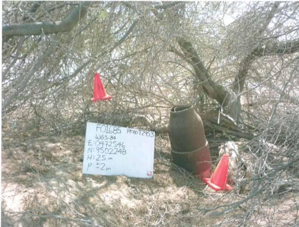
Fotografía N° 1. Pozo inactivo de la ficha F01685 que muestra casing de superficie a 0,63 m sobre el nivel del suelo, 9 plg de diámetro y sin accesorios que aseguren su hermetismo.
