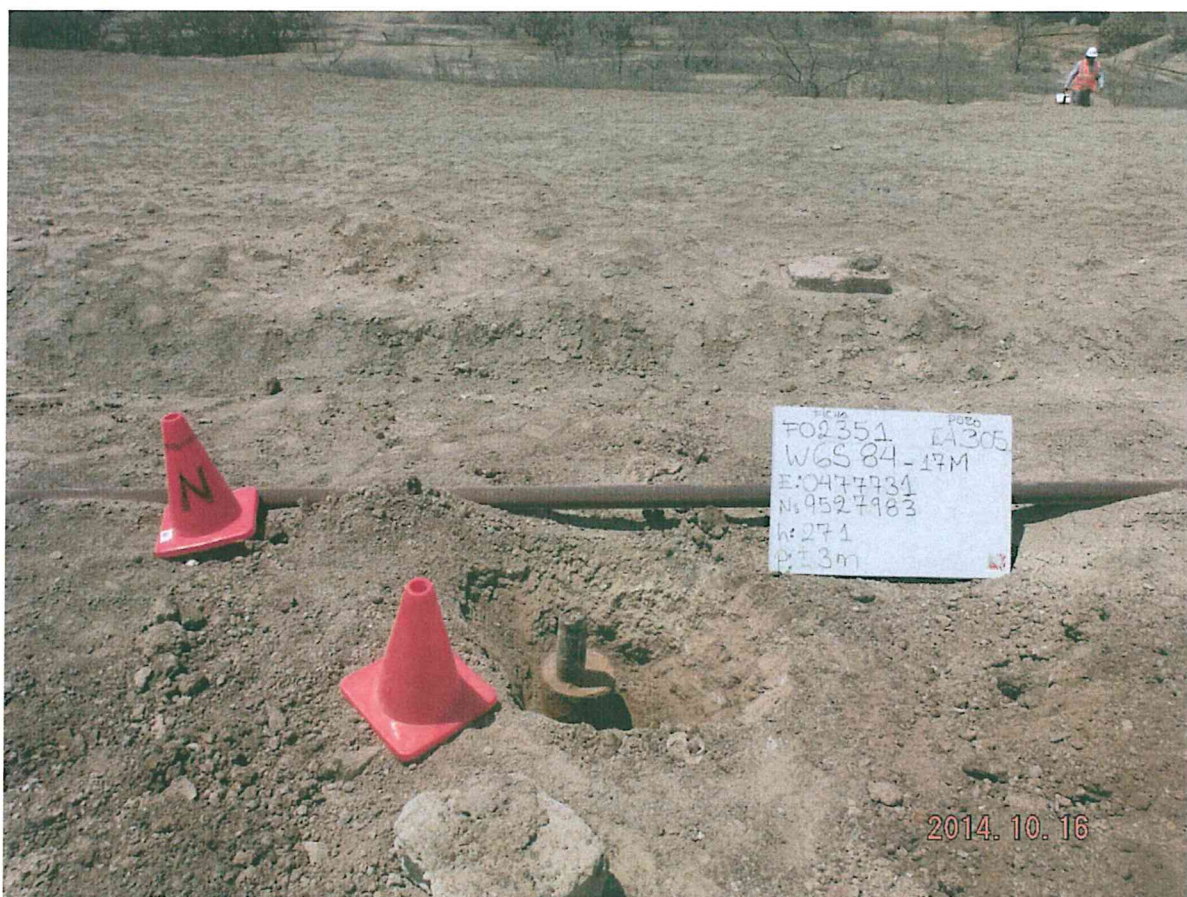
Fotografía N° 1. Pozo A_305, en el que se visualiza una tubería que se encontraba soldada a la plancha que cierra el pozo, la cual se encontraba cortada a 0,25 m de altura y habría sostenido el número del pozo.
