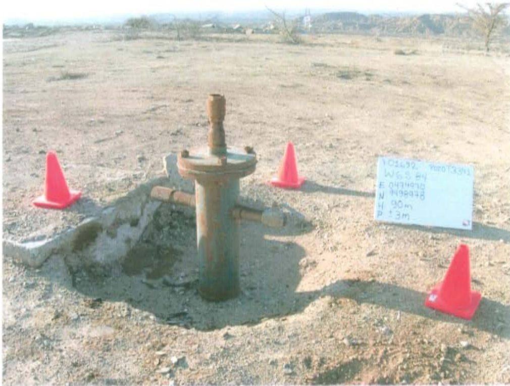
Fotografía N° 1. Identificación del pozo inactivo con código PERUPETRO T3341. Presenta casing con válvula pero que no aseguran su hermetismo.
