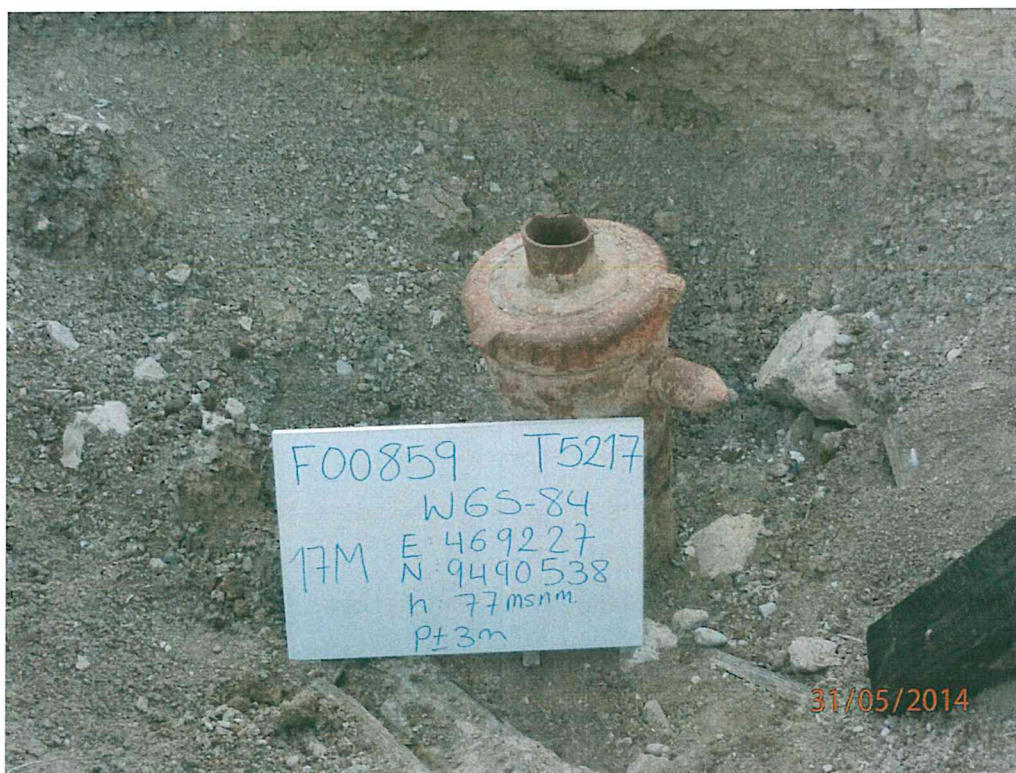
Fotografía N° 1. Pozo inactivo sin cabezal ni válvula y se encuentra abierto y expuesto al ambiente.
