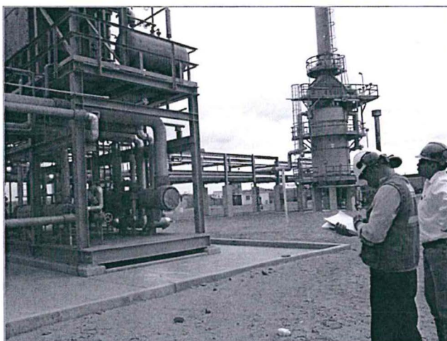
Fotografía N° 3. Durante el recorrido de las instalaciones de la Procesadora de Gas Pariñas SAC. 28 de mayo 2014.
