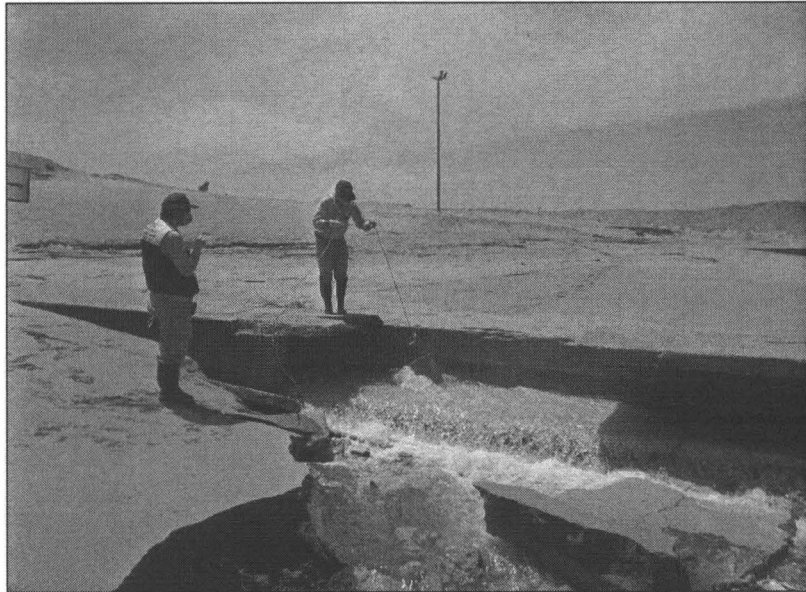
Foto 2: Efluente de Desagüe Limpio, con aguas claras y ligeramente calientes.
