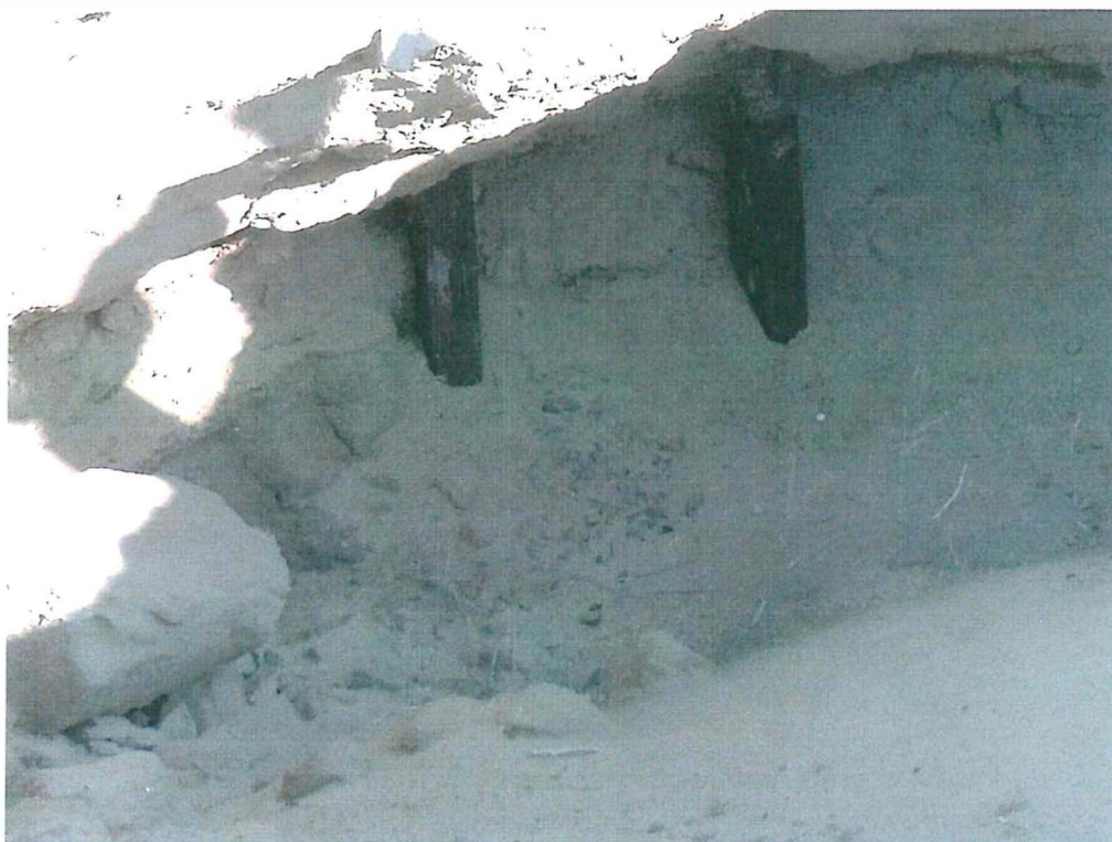
Fotografía N° 3. Obsérvese bloques de concreto en el interior de excavación.
