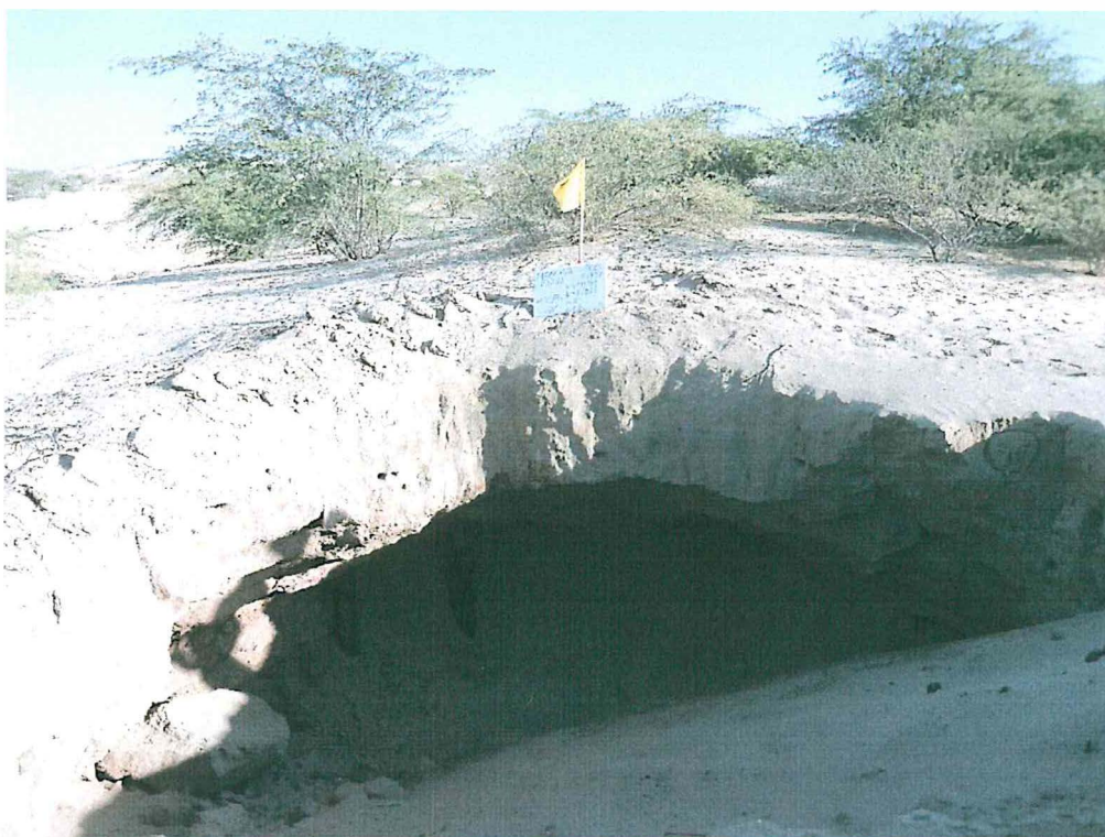
Fotografía N° 1. Pozo T2753 no ubicado superficialmente y que se encontraría enterrado, se observan dos (2) bloques de madera en el interior de una excavación.
